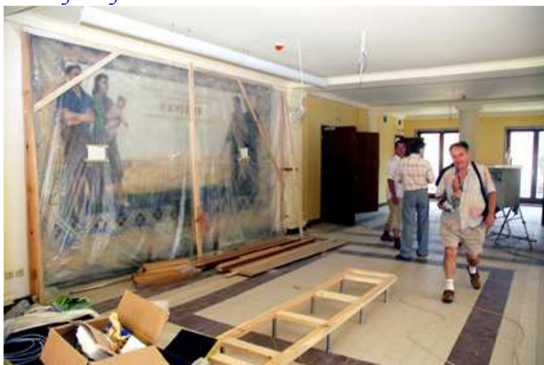
Foyer v 1. poschodí s repasovanou malbou.
