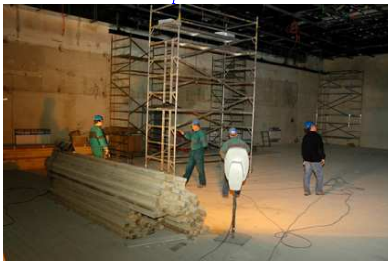
Budování víceúčelového sálu.
