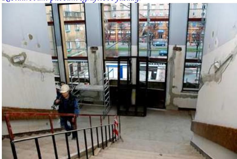
Pohled z hlavního schodiště v patře.
