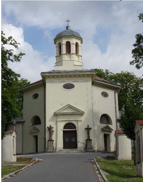
Kostel sv. Jindřicha s několika kapličkami křížové cesty (celkem 14) z poloviny 19. století.
