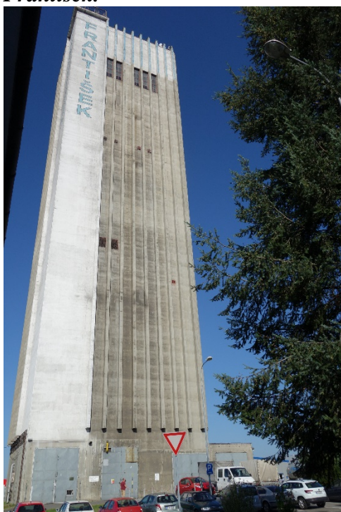
Věž bývalého Dolu František v Horní Suché.
