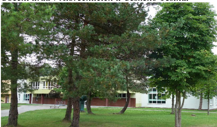
Základní škola v Albrechticích u Českého Těšína.
