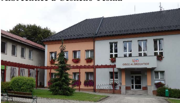
Obecní úřad v Albrechticích u Českého Těšína.
