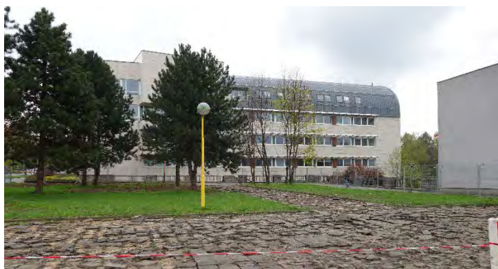
Začala oprava prostranství u KD Leoše Janáčka směrem k budově soudu.
