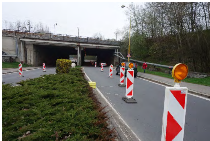
Začala rekonstrukce železničního podjezdu, doprava je stažena do jednoho jízdního pruhu.
