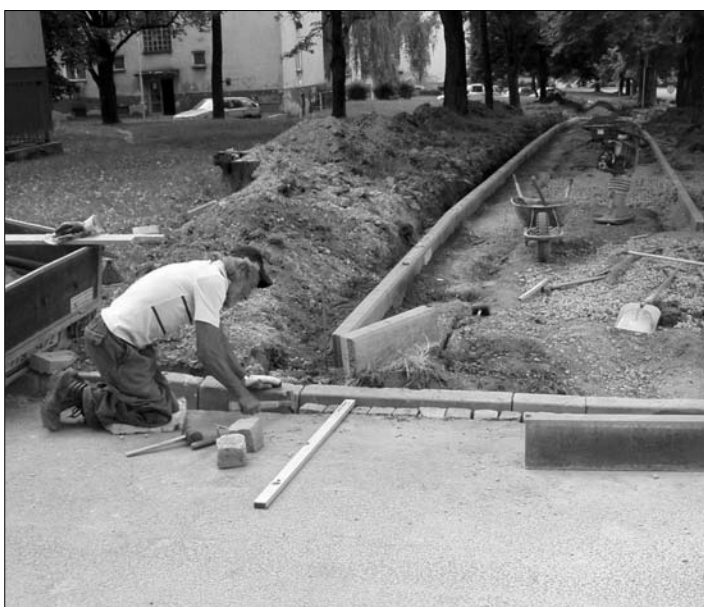
Chodník na Jarošově ulici stál 634 tisíc korun.
