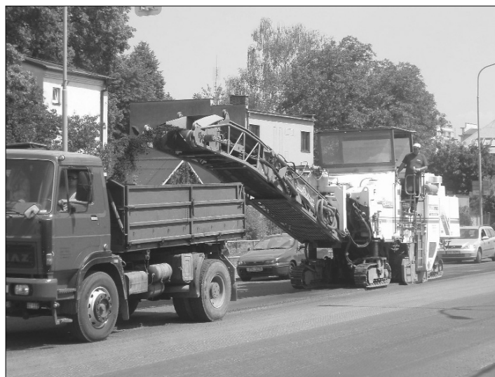
Opravovala se také řada vozovek ve městě. Radnice na ně vynaložila více než 22 milionů korun. Snímek je z opravy silnice Těšínská, kterou financovalo Ředitelství silnic a dálnic. Vybroušení a položení nového povrchu za omezeného provozu vyšlo na 3,4 milionu korun.
