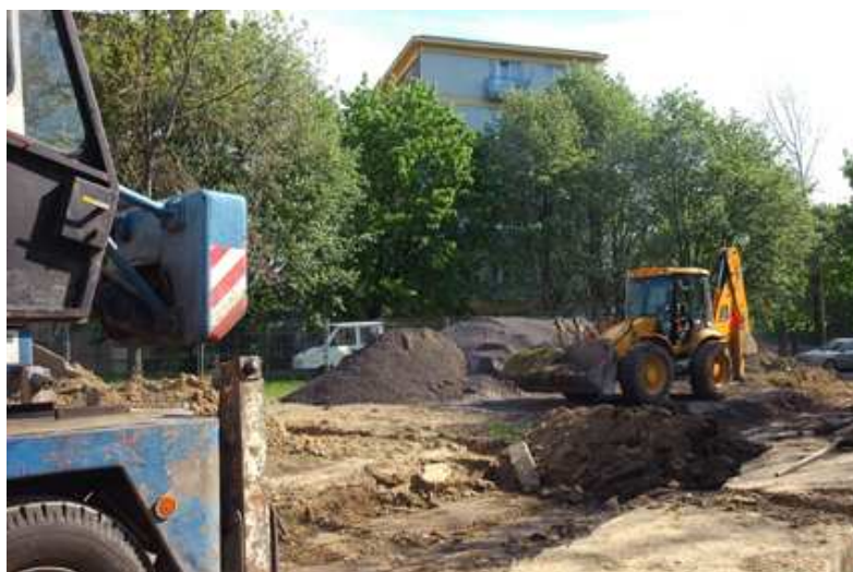
První práce na výstavbě domova důchodců.
