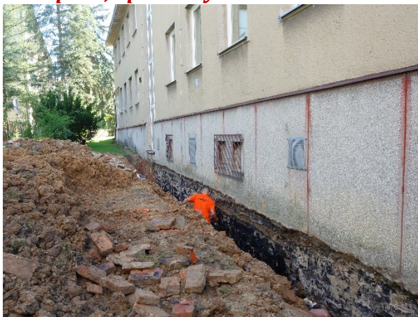
MŠ Lípová, oprava hydroizolace suterénu objektu. Foceno 13. července 2022.
