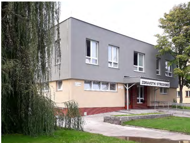
Opravené zdravotní středisko na Studentské ulici v Havířově-Podlesí.
