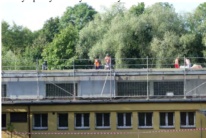
Oprava střechy tělocvičny ZŠ Kudeříkové ve středu 24. července 2019.
