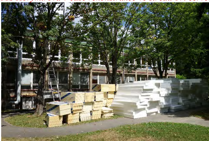
MŠ Horymírova v čase rekonstrukce ve středu 17. července 2019.
