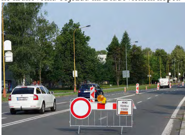
Plošná oprava silnice Těšínské, středa 14. srpna 2019.
