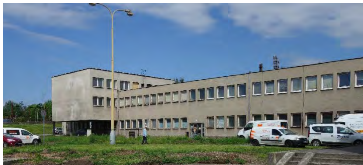
Začíná rekonstrukce vlakového nádraží v Havířově. Pátek 24. května 2019.
