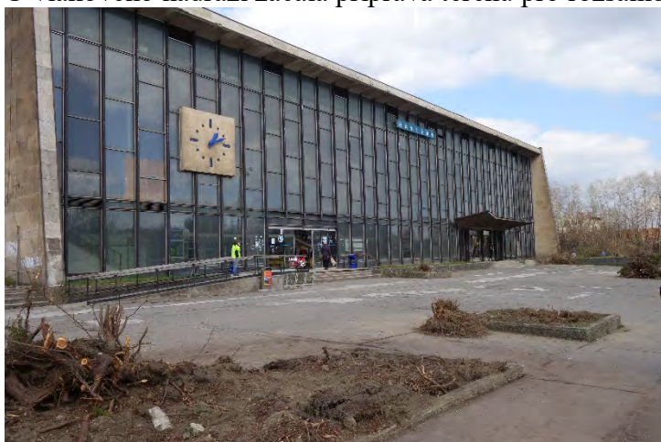
Přednádražní prostor se začne rekonstruovat. Středa 20. března 2019.
