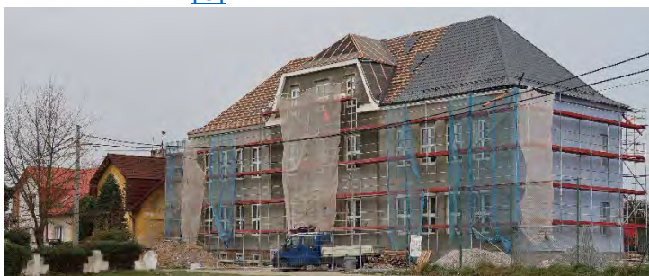
Celková rekonstrukce MŠ v Havířově-Dolní Suché v úterý 5. listopadu 2019. Foto z archivu Jana Szturze.
