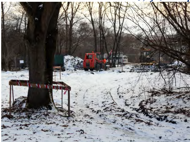
Buduje se nový most přes řeku Lučinu, stroje pracují také v sobotu 14. ledna 2017.
