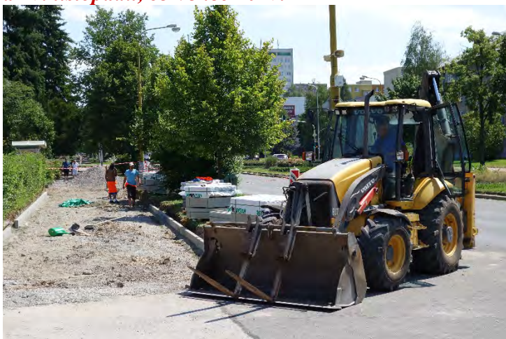
Budují se nové chodníky a nová cyklostezka, červenec 2017.
