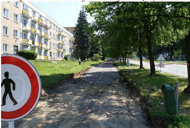
Stavební práce začaly i na chodníku podélně s ulicí Dlouhá, od křižovatky s ulicí 17. listopadu směrem k prodejně Albert.
