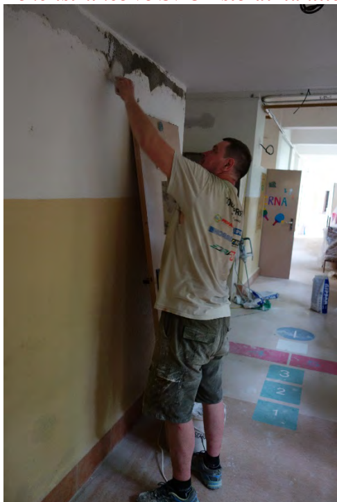
Výměna elektroinstalace ve SVČ Asterix na ulici M. Kudeřikové.
